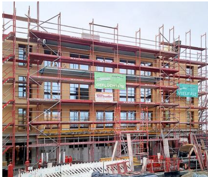
Baustelle Baugenossenschaft BeGeno16 eG
